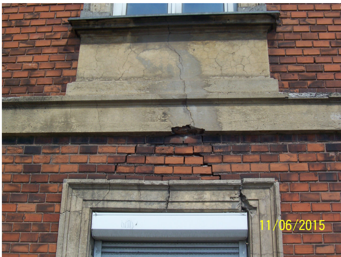
Fot.1. Zarysowania ściany i obramowania okna parteru na elewacji zachodniej
