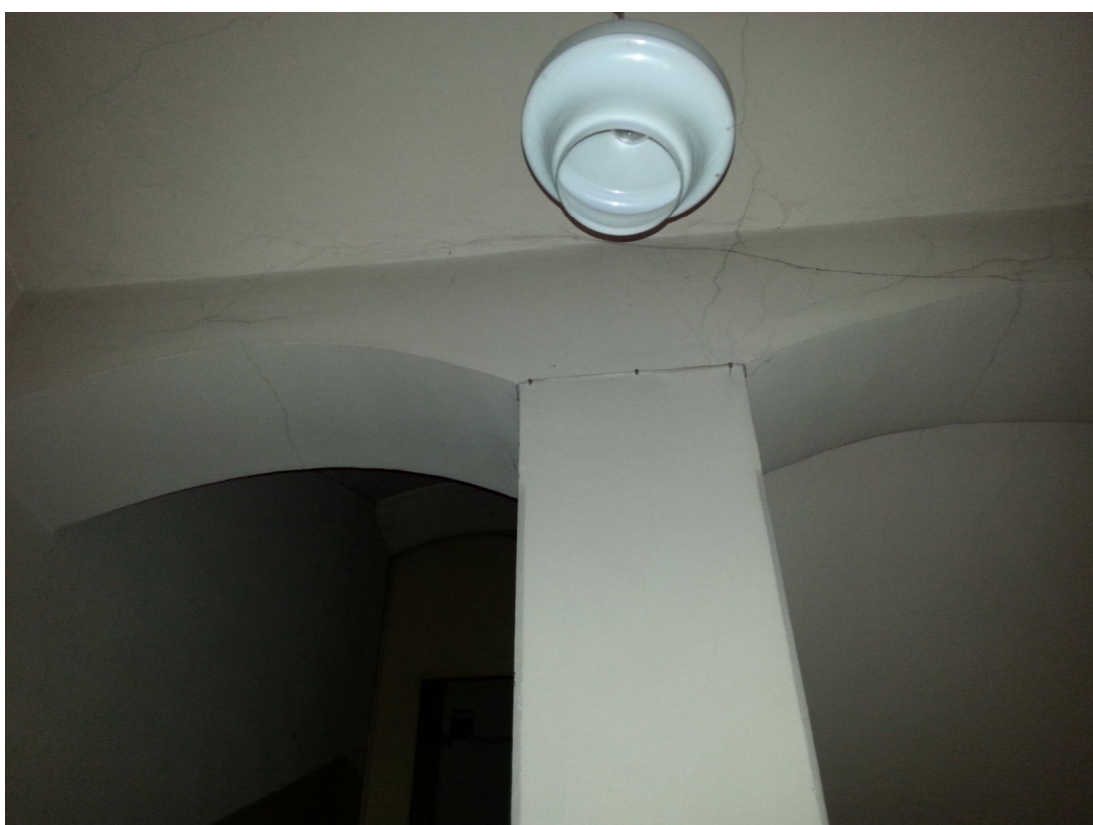
Fot.5. Zarysowane łuki ceglane na klatce schodowej
