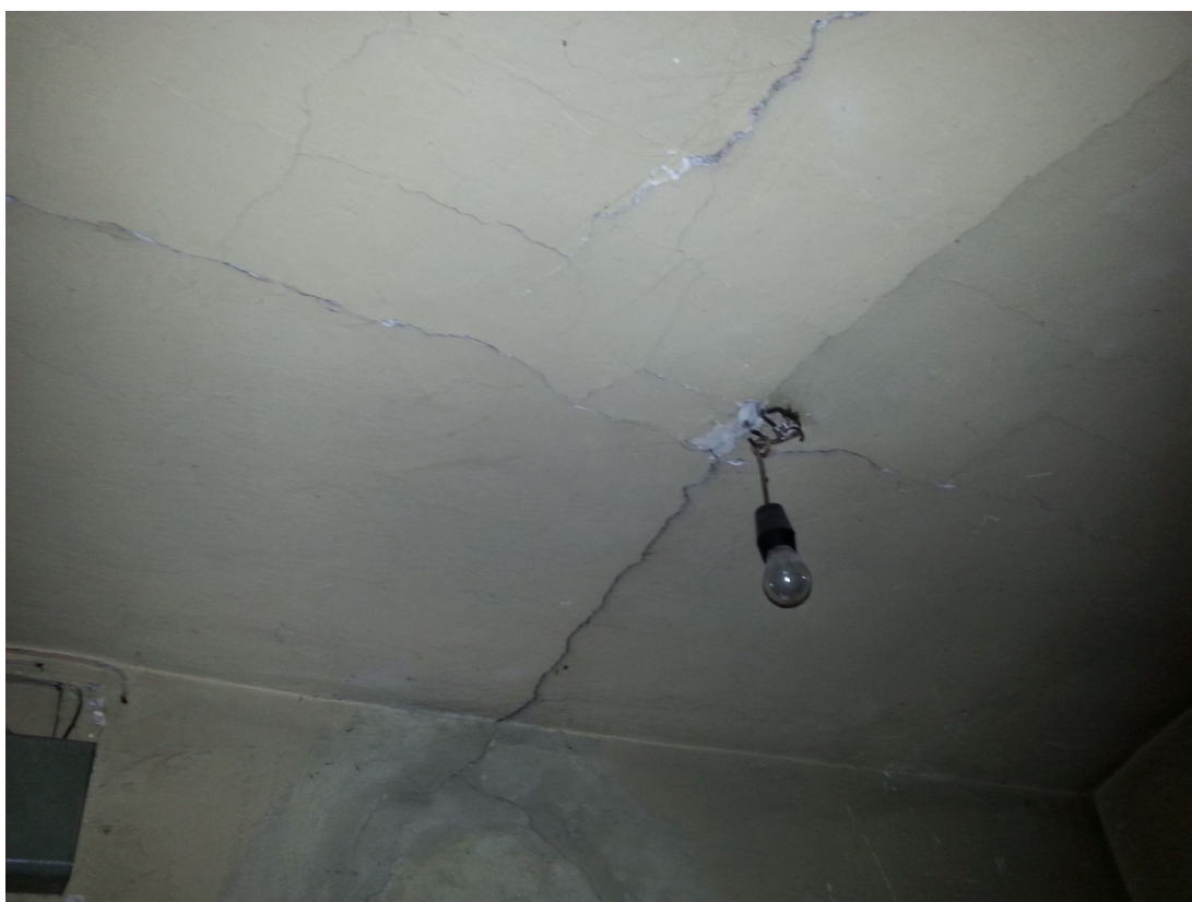
Fot.6. Zarysowania ściany i stropu spocznika pod strychem
