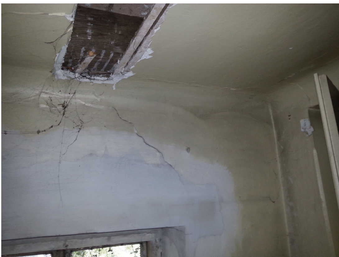
Fot.7. Zarysowanie wewnętrzne ściany wschodniej w pomieszczeniu na półpiętrze pod strychem
