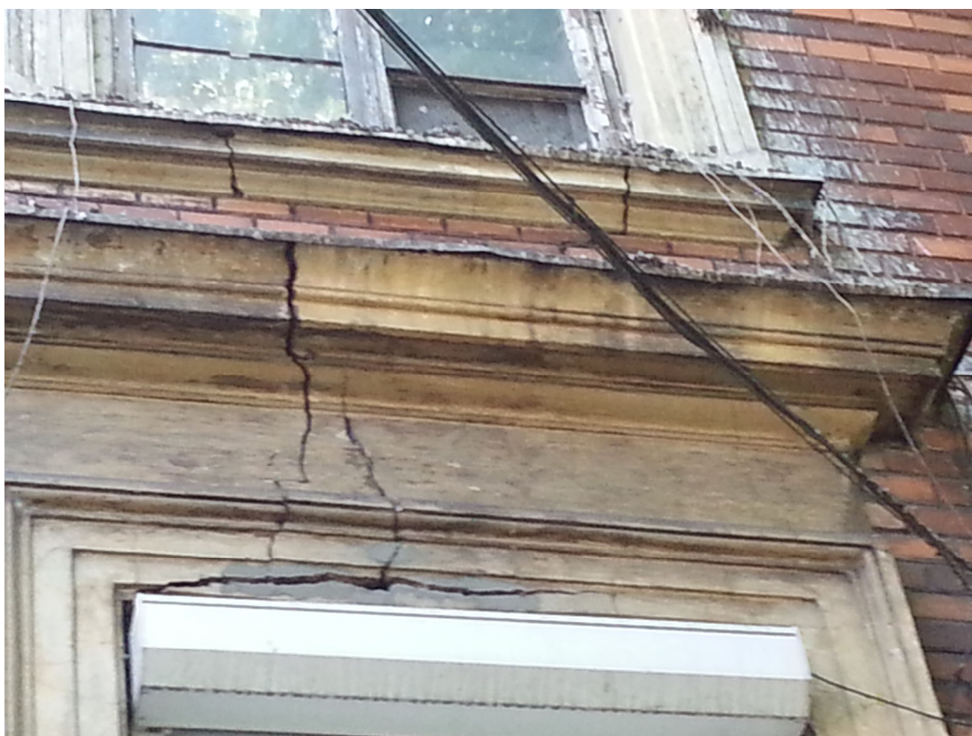
Fot.2. Zarysowania ściany i obramowania okna parteru na elewacji wschodniej
